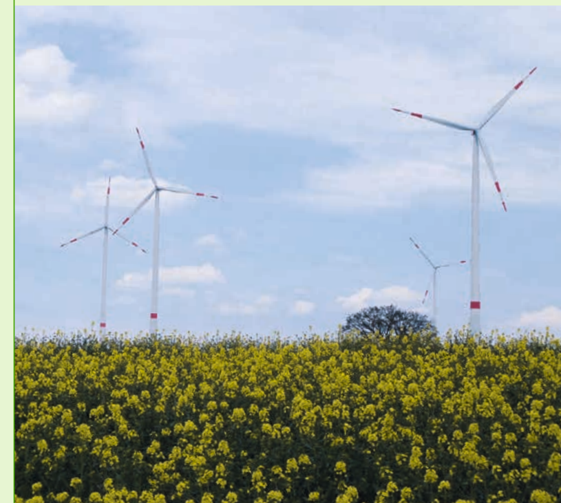
Windpark Groß Schwiesow
