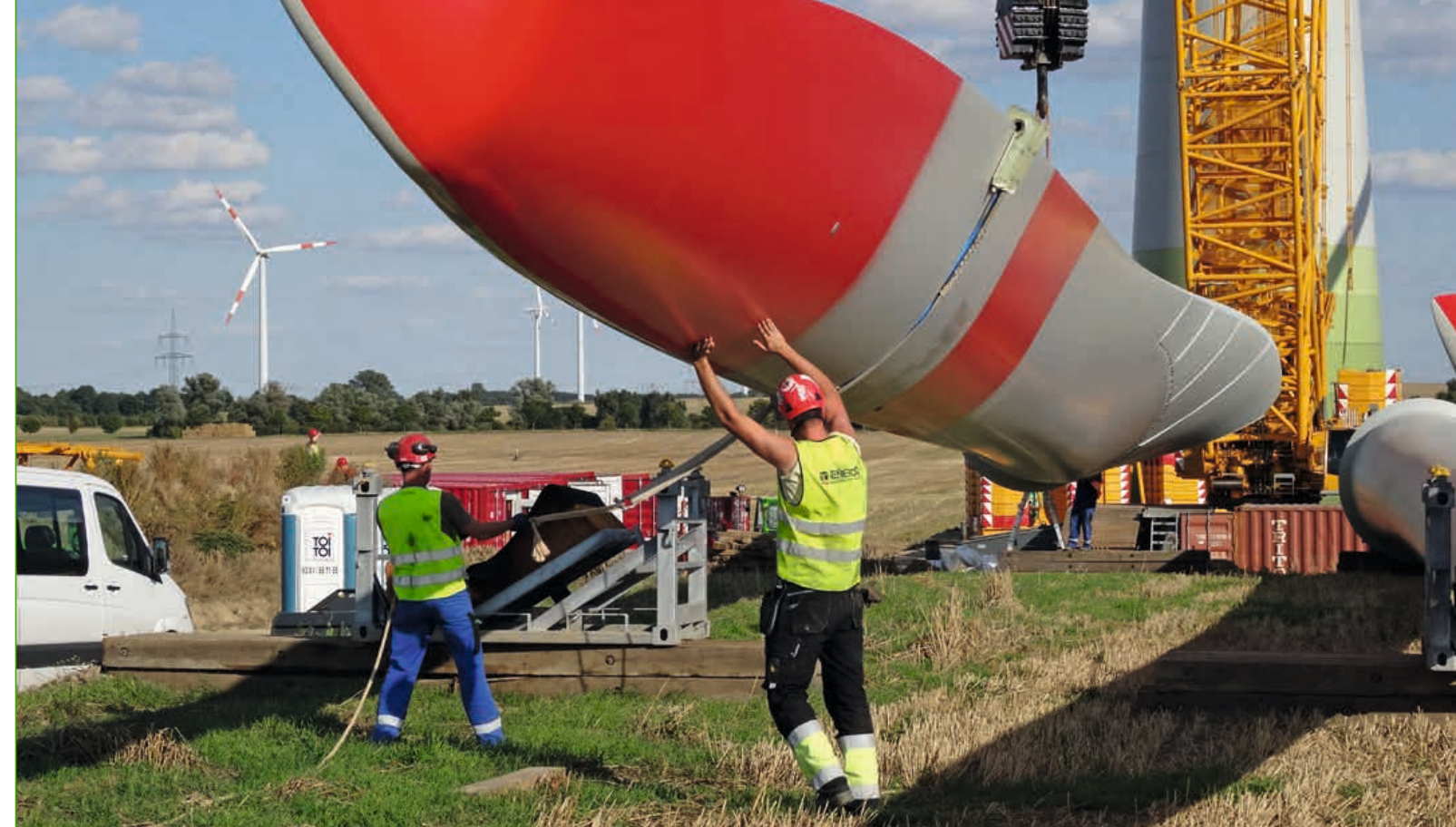
Bau einer Windkraftanlage im Windpark Groß Schwiesow im Jahr 2015
