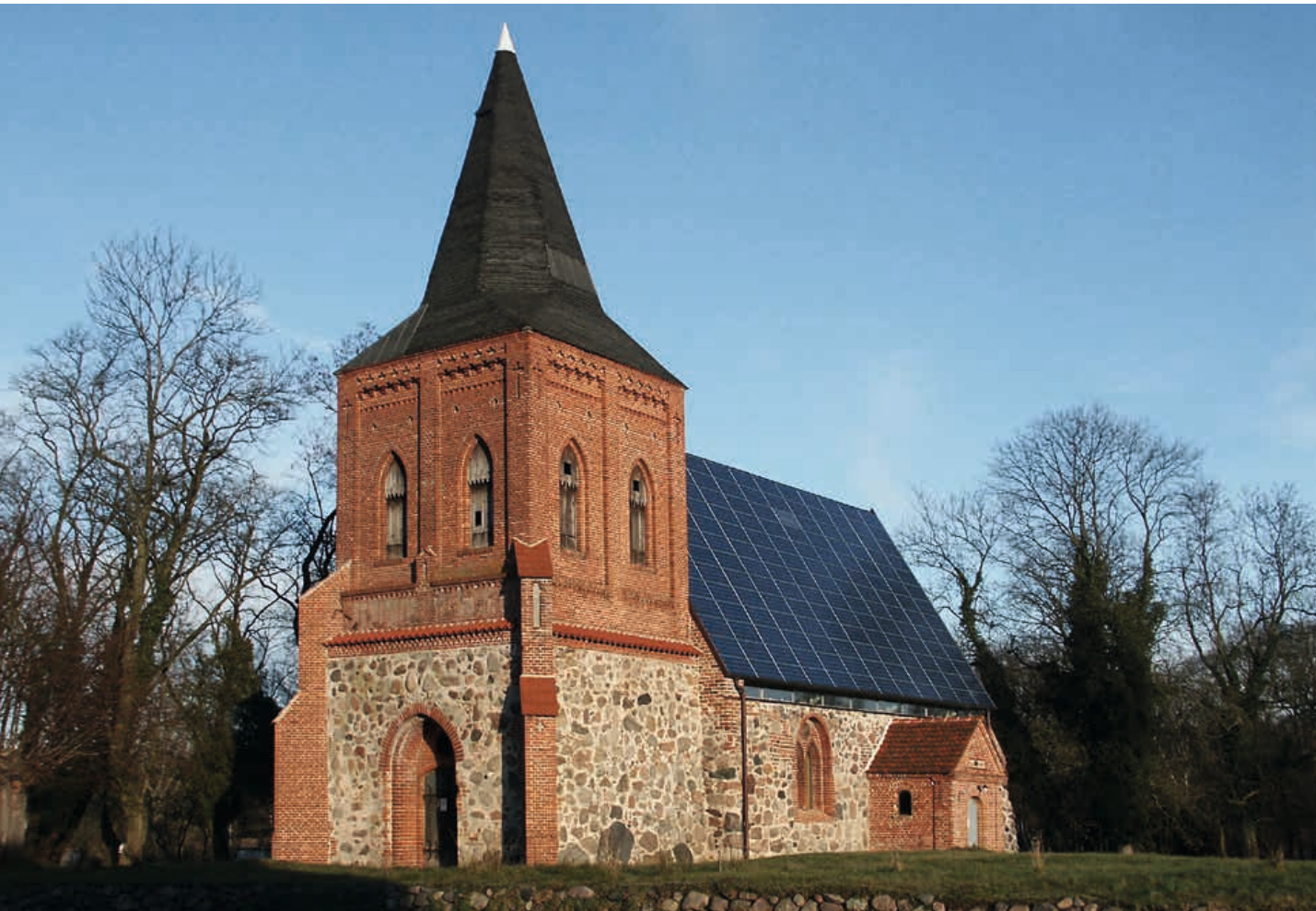
Die unter Denkmalschutz stehende Dorfkirche aus dem 13. Jahrhundert in Zernin trägt nach ihrer Wiedereinweihung auf der südlichen Hälfte eine Photovoltaikanlage.
