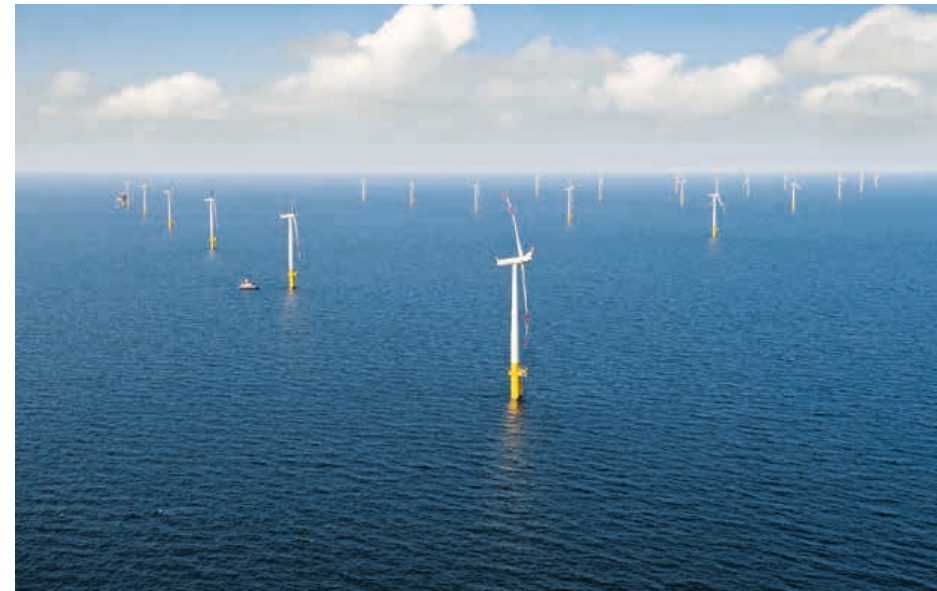
Der Offshore-Windpark Baltic 2, 32 Kilometer nördlich der Insel Rügen, hat knapp ein Drittel größere Windräder als Baltic 1, ist viermal so groß und kann sechsmal so viel Strom erzeugen.
