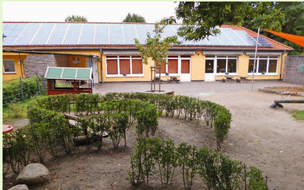
Kindertagesstätte mit Photovoltaikanlage in Retschow
